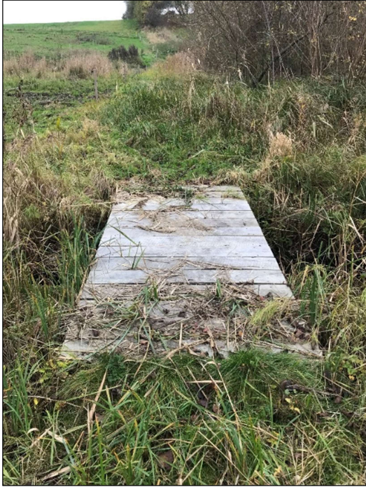
Figur 5 Eksempel på en af de små gangbroer der etableres over åen i ådalen.
