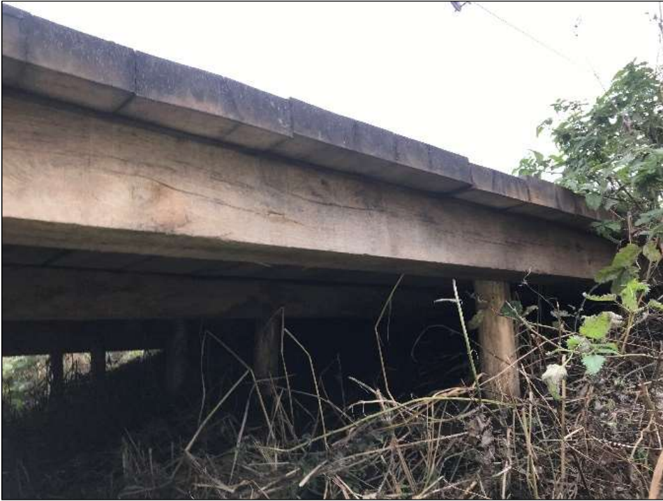
Figur 7 Underkonstruktion på bro, eksempel. Brinken bibeholdes i dens naturlige form under broerne.
