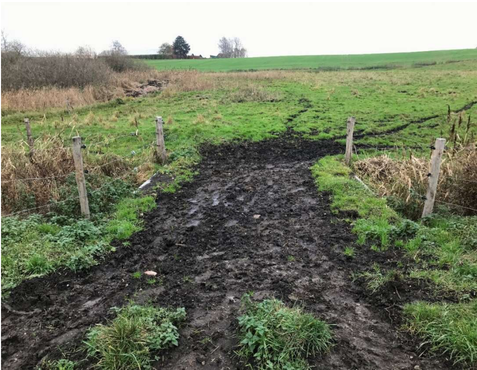
Figur 6 Kvægovergang, 4 m bred. Udført i ubehandlet eg. Der er jord på for at få kvæget over her til en start. Der er lille kant på for at sikre mod jord i vandløbet. Senere kan jorden muligvis fjernes. Der er dyrehegn på hver side af broen.
